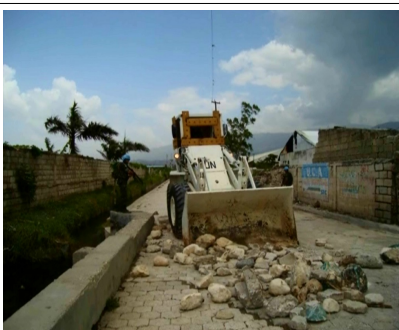
Figura 2 – pá carregadeira com proteção improvisada de cabine em ação, na limpeza de vias de acesso ( BRABAT/2 )
